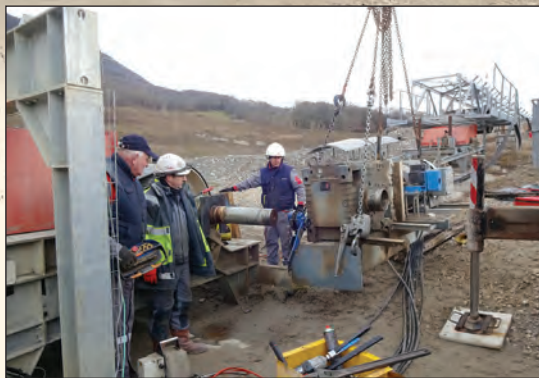
Démontage d'un des deux motoréducteurs SEW de la série MC, à la carrière Famy, de Lancrans (01).
